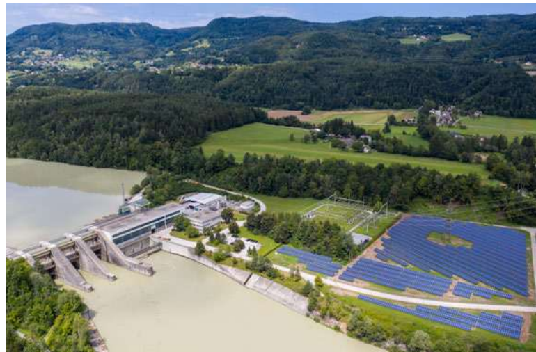
Gelände des Draukraftwerks in Ludmannsdorf/Bilčovs, Foto: Verbund AG
